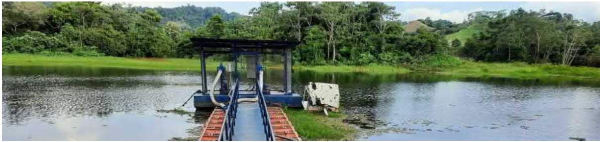
Proyecto “Construcción plan maestro de acueducto del corregimiento El Totumo del municipio de Necoclí” Urabá, Municipio de Necoclí. Barcaza captación de agua corregimiento El Totumo. Gerencia de Servicios Públicos – Gobernación de Antioquia
