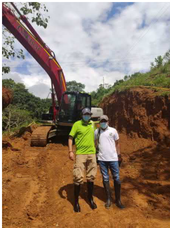
Comienzo de obra de la vía de acceso al predio Becuarandó Hogar de reincorporados en el municipio de Mutatá Gerencia de Paz y Posconflicto – Gobernación de Antioquia
