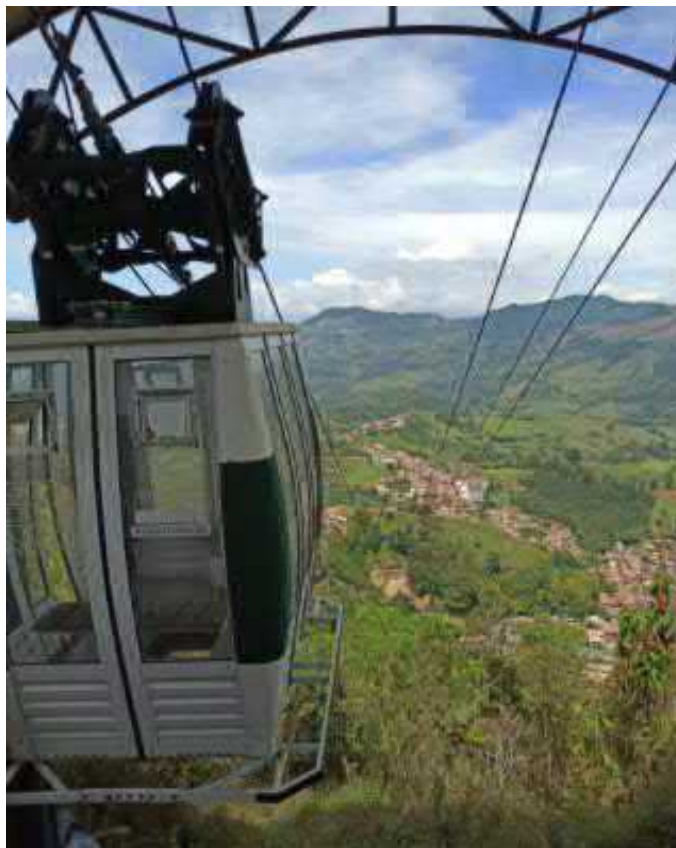
Cable Aéreo Suroeste, Municipio de Jericó Secretaría de Infraestructura Física (SIF) - Gobernación de Antioquia
