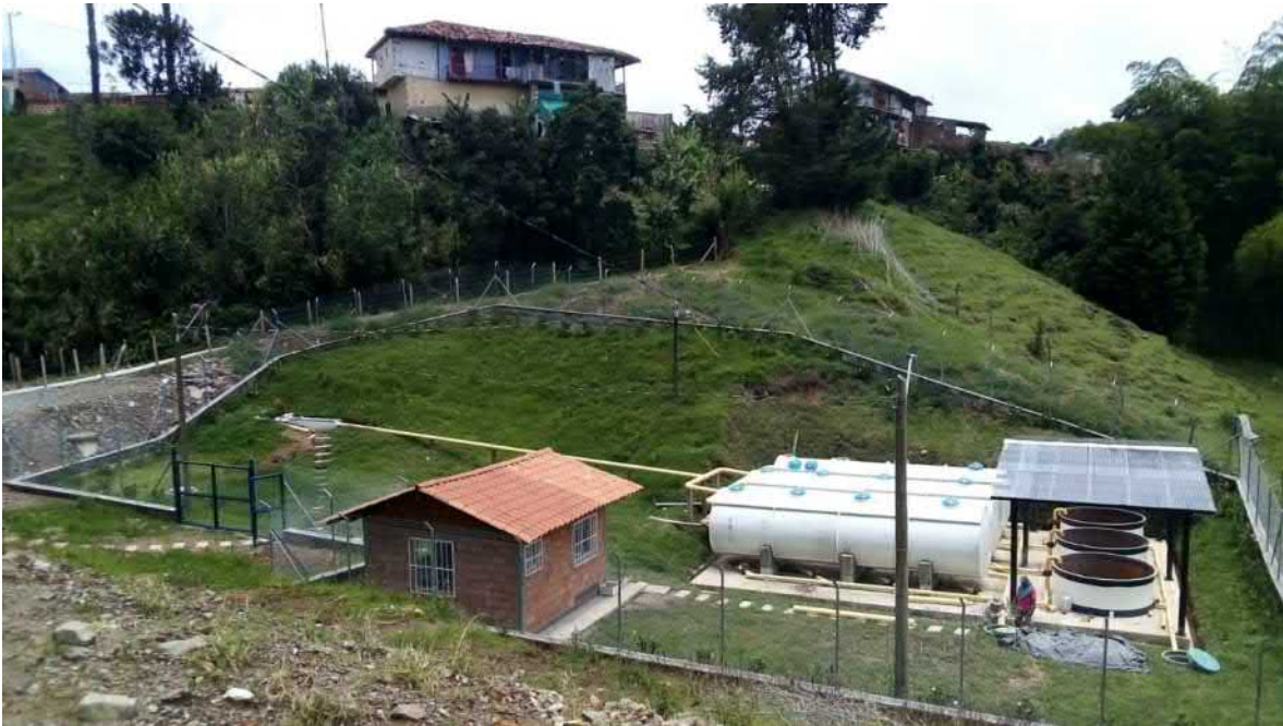
Proyecto "Construcción del plan maestro de acueducto y alcantarillado del corregimiento de Pantanillo, Municipio de Abejorral" Oriente, Municipio de Abejorral. Planta de Tratamiento de Aguas Residuales (PTAR). Gerencia de Servicios Públicos – Gobernación de Antioquia
