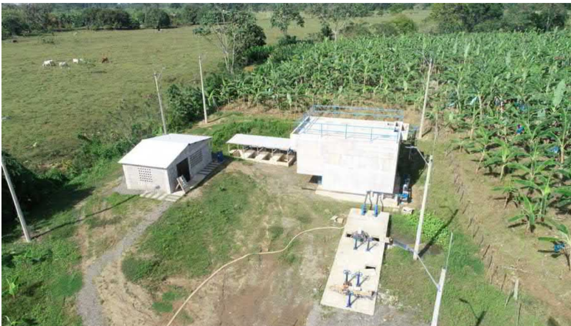
Proyecto "Construcción del plan maestro de acueducto y alcantarillado corregimiento El Silencio" Urabá, Municipio de Carepa. Planta de Tratamiento de Aguas Residuales (PTAR), corregimiento El Silencio. Gerencia de Servicios Públicos – Gobernación de Antioquia
