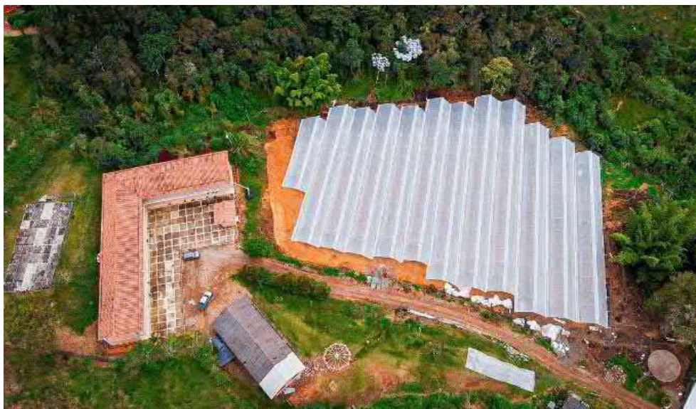
Construcción real de la Ciudadela Agrotecnológica del oriente Antioqueño Vereda San José, Municipio de Marinilla, Antioquia
