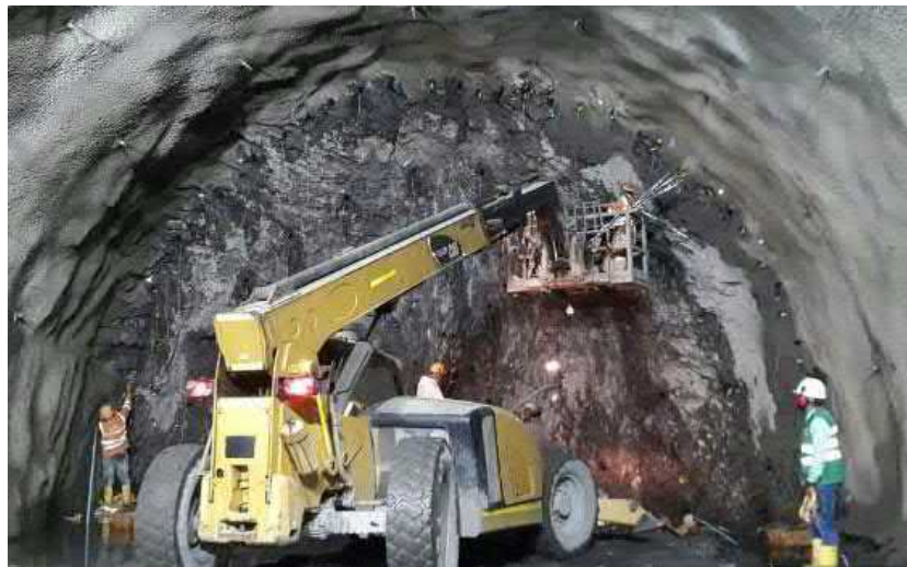
Avance construcción del Túnel Guillermo Gaviria Echeverri (TGGE) Secretaría de Infraestructura Física (SIF) - Gobernación de Antioquia
