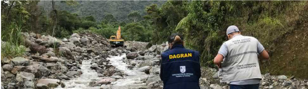
Intervención con maquinaria amarilla – Salgar - DAPARD – Gobernación de Antioquia
