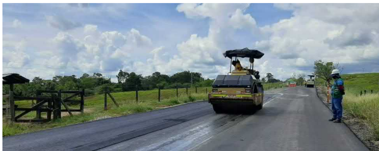
Inicio Pavimentación Vía Mulas-Cruces-Puerto Nare
